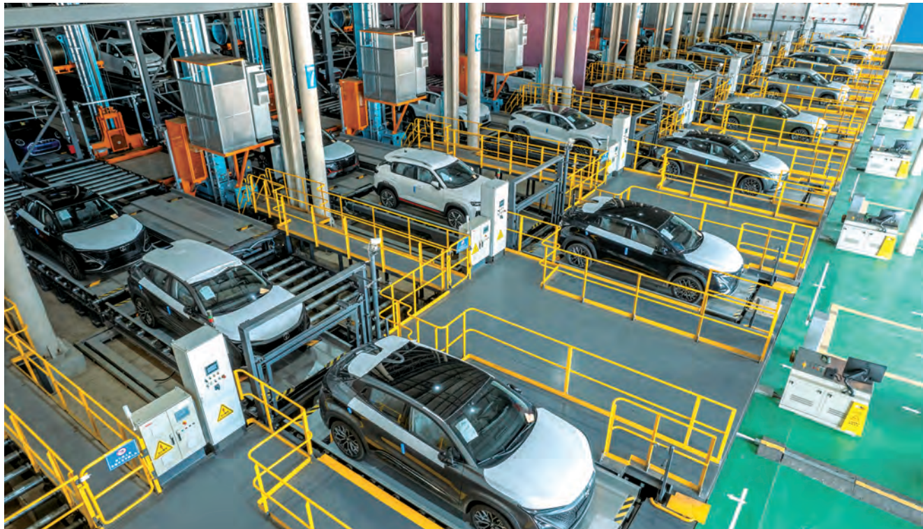
上海港自动化立体仓库内部场景
