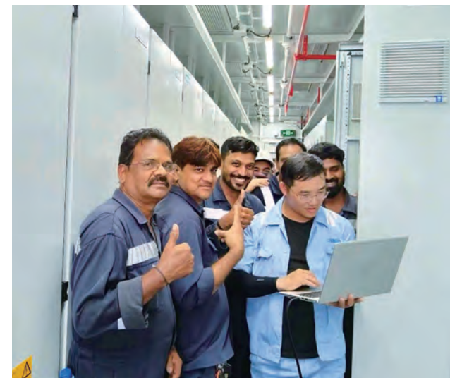
王义军正在为用户进行岸桥调试培训
